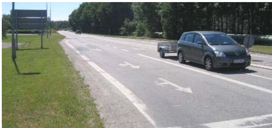
Figur 4.6: Asnæsvej mod Asnæs og Ny Vesthavn
