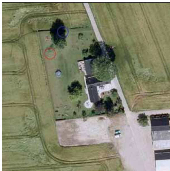
Figur 2.4. Flytning af husstandsmølle ved Slibestenen 11. Nuværende placering markeret med blå og ny placering markeret med rødt.
