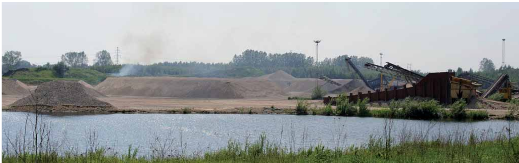
Foto 4.2 Udsigt mod syd fra Kaldredvej over Kaldred Grusgrav, hvor maskinerne er i fuld sving.
