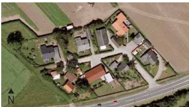
Foto 5.15 Kalundborgvej 96-110 nord for hovedvejen. Det nordligste hus er nabobolig 11.
