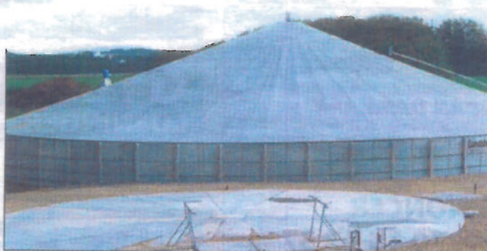
- Det, der oprindeligt var vigtigt for mig, var ikke at tjene en masse på biogas. Her ses de to overdækkede tanke på Gedsted Nørgaard i Gedsted i Himmerland.
