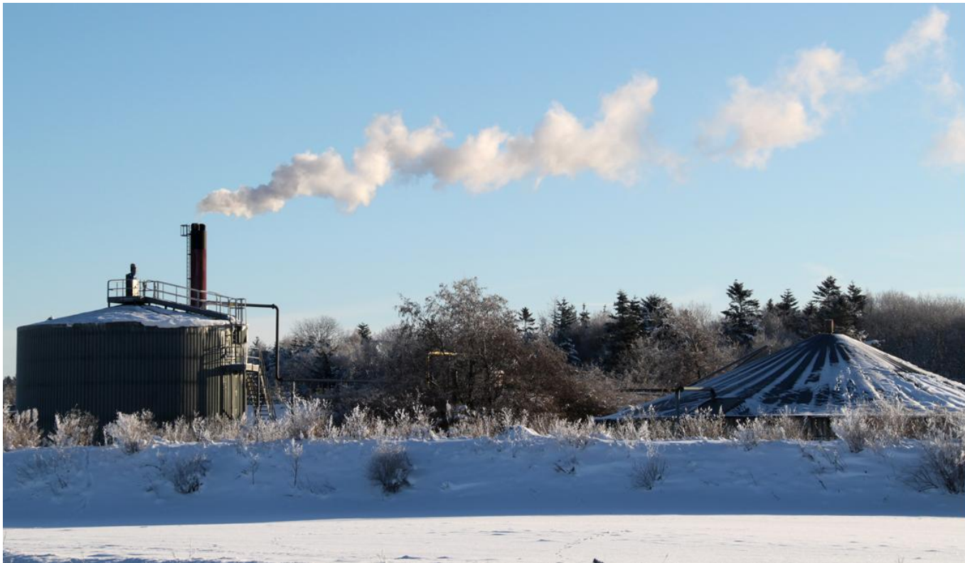
Billedet viser et eksempel på biogasanlæg i Danmark; Kilde: Biogassekretariatet.
