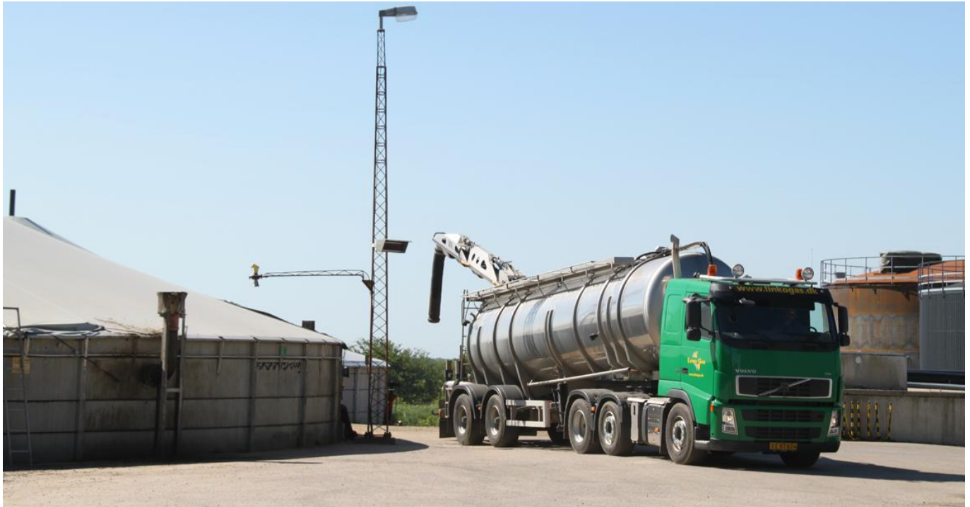
Billedet viser et eksempel på biogasanlæg i Danmark; Kilde: Biogassekretariatet.
