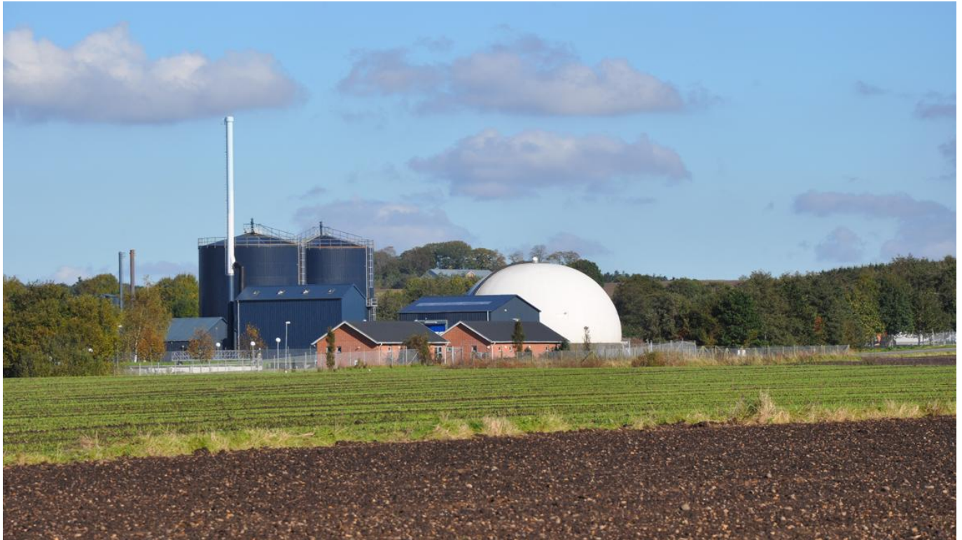
Billedet viser et eksempel på biogasanlæg i Danmark; Kilde: Biogassekretariatet.
