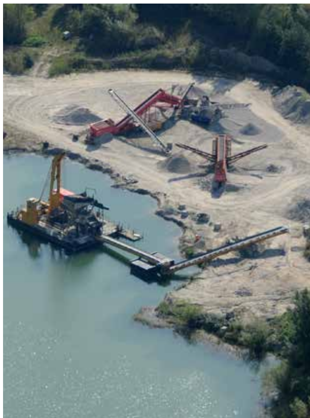
Gravning under grundvandet ved Gundsømagle.
