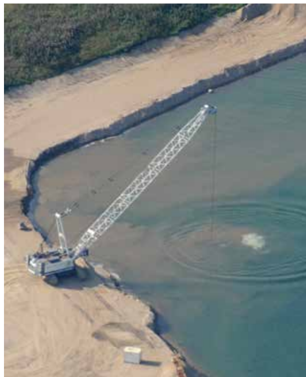
Råstofgravning under grundvandsspejl.
