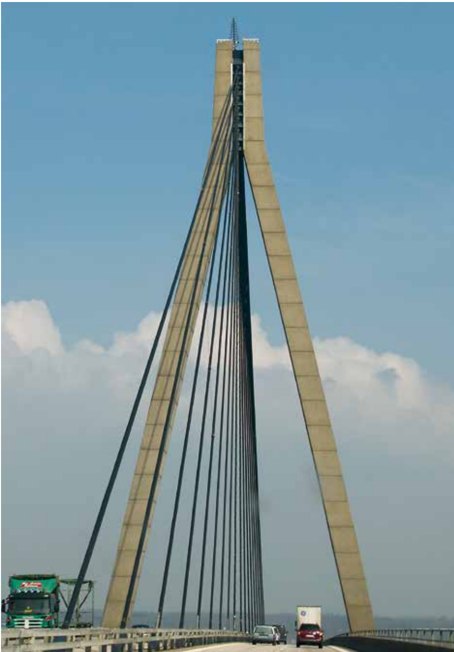
Farøbroen. Materialer til brobyggeri hentes primært fra havet.
