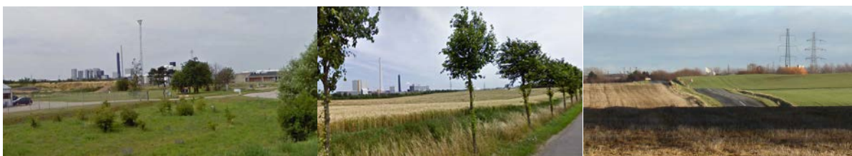
Figur 2: Fra venstre indgangen til renseanlægget (Sydhavnsvej og Dokhavnsvej), Lerchenborg Gods og Asnæs Skovvej.
