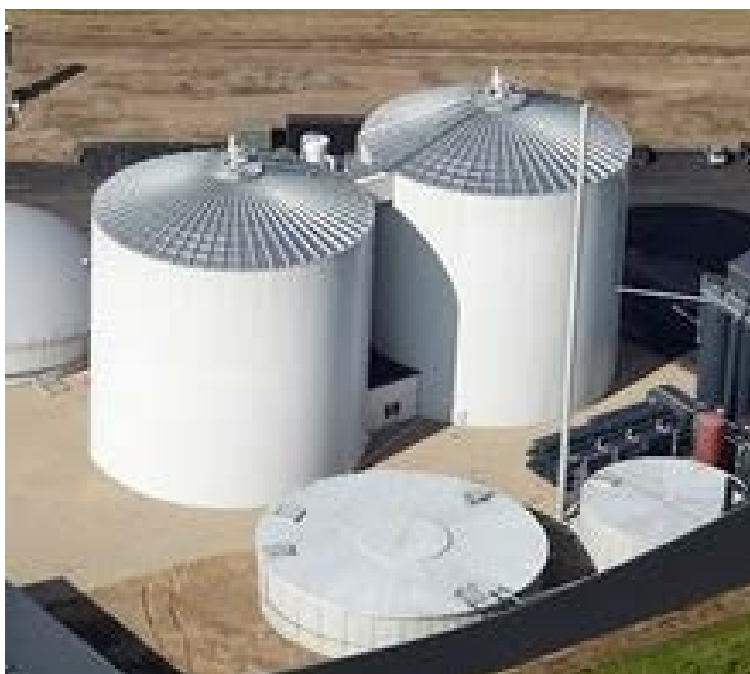
Figur 19: Eksempel på biogasreaktorer og modtagetank (forrest i billedet). De 2 reaktortanke på fotoet er på hver 8.000 m 3 .
