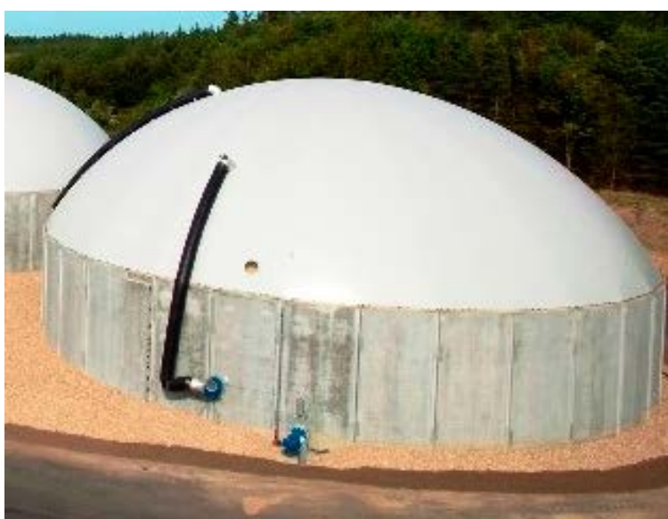
Figur 21: Lager tank med gaslager på toppen.
