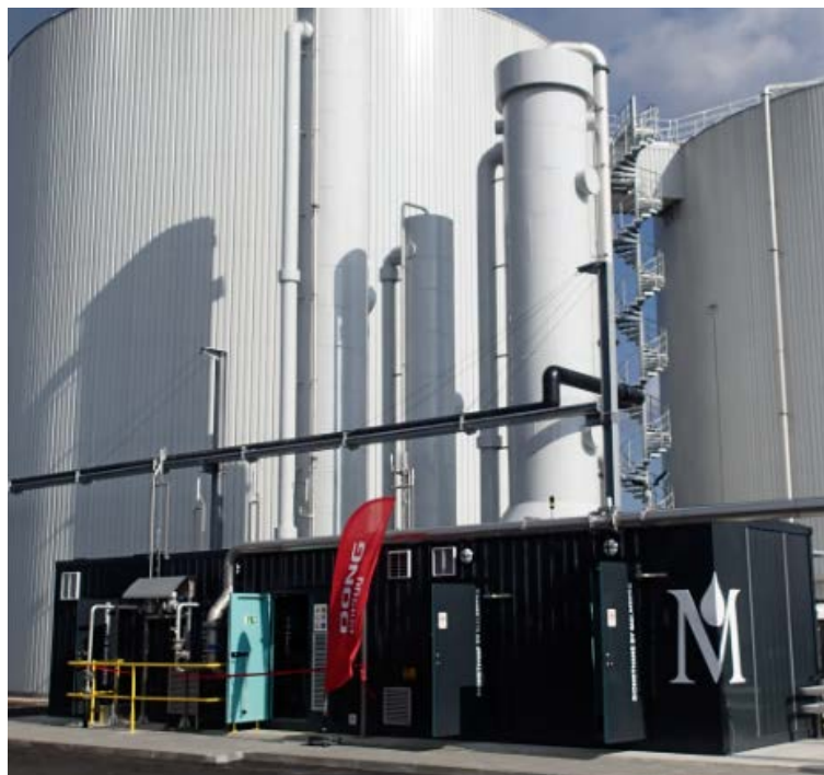
Figur 22: Foto af anlæg, der opgraderer biogassen vha. absorption ved trykvandskrubning.
