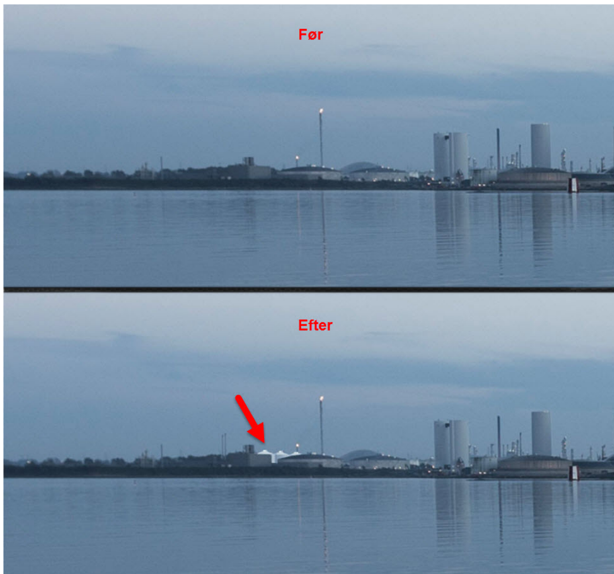
Figur 49: Fotostandpunkt 2, Gisseløre halvø.
