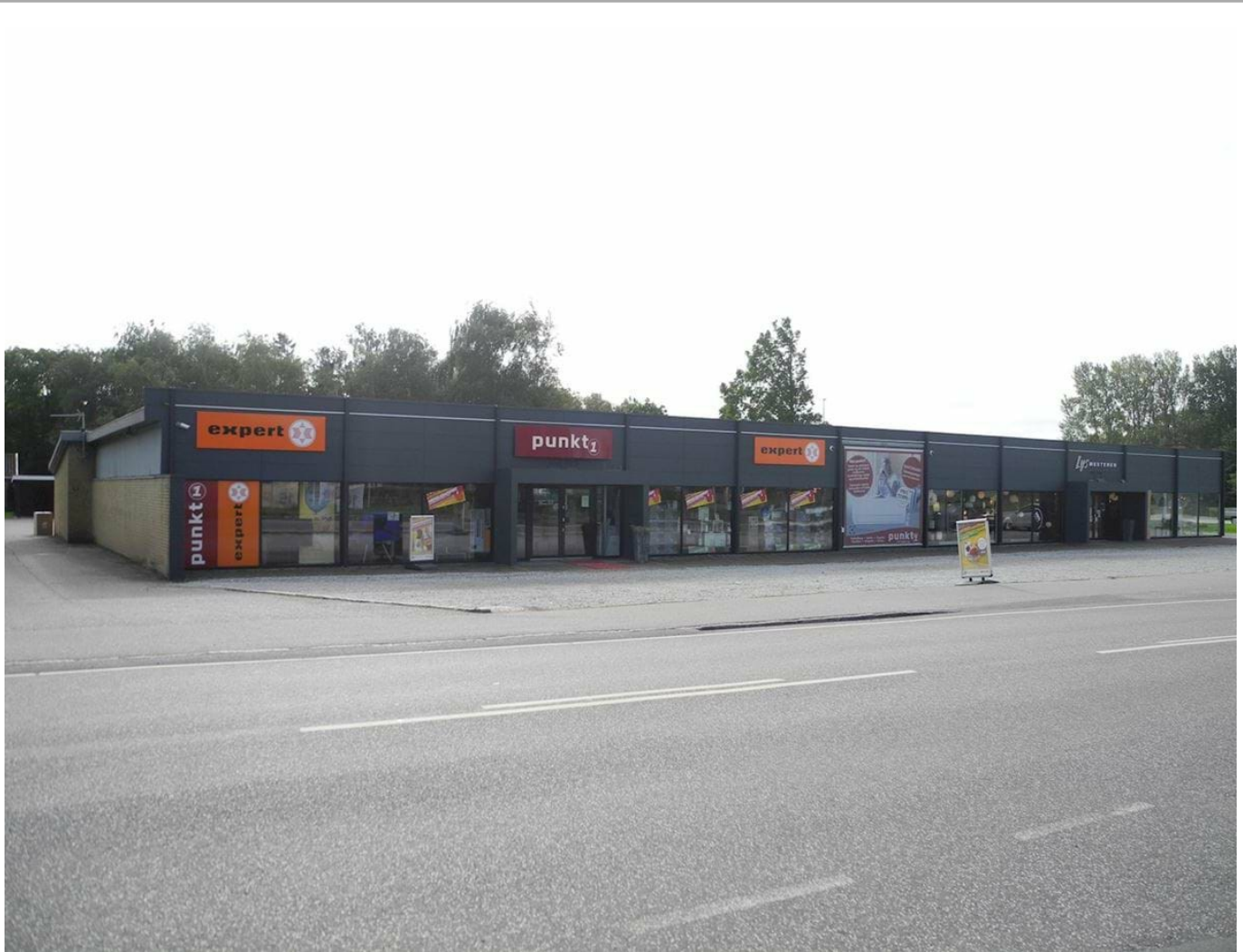
Foto (2021) Lokalplanområdets eksisterende bygning med tilhørende parkeringsareal set fra Kirkevangen
