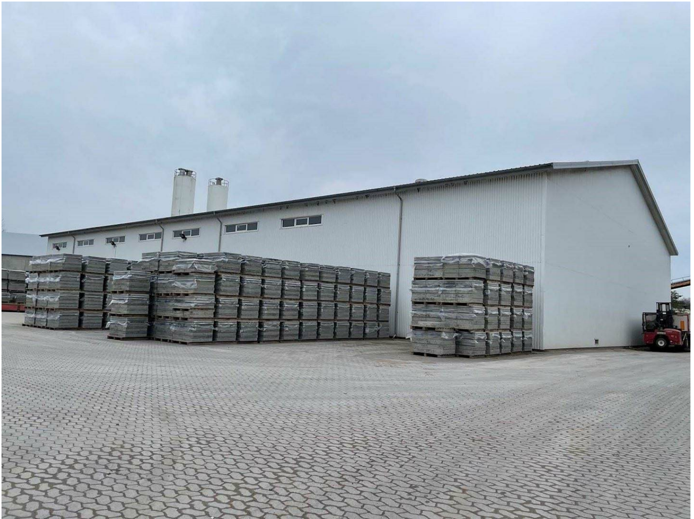
Figur 5 - Eksempel på lager- og oplagsplads ved lignende byggeri
