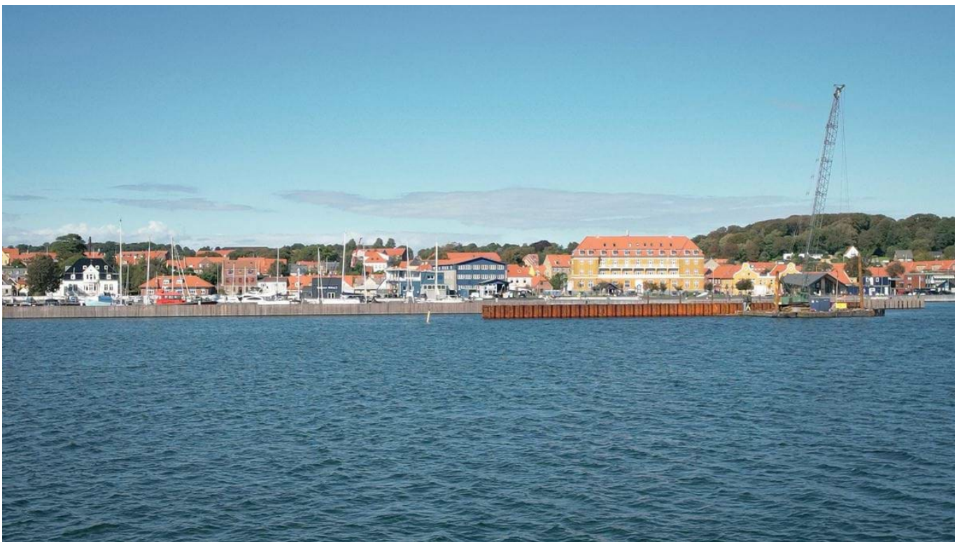
Billede af de eksisterende forhold på Havneparken set fra syd mod nord, fotostandpunkt DJI_0015.
